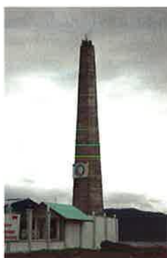
海辺に建設中の 津波の高さを示す塔
