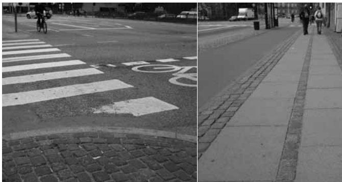
左：横断歩道の段差解消コンクリート舗装。右：通行帯敷設
