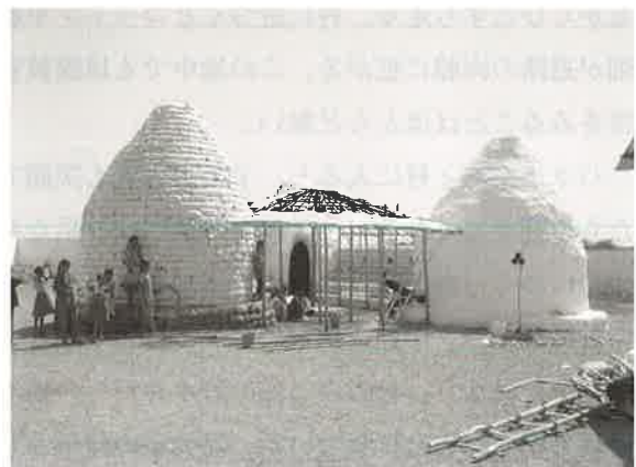
屋根の骨組みが完成したボンガ図書館
