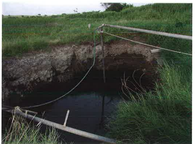
チェックダムによる効果 ー付近の井戸の水量ー
