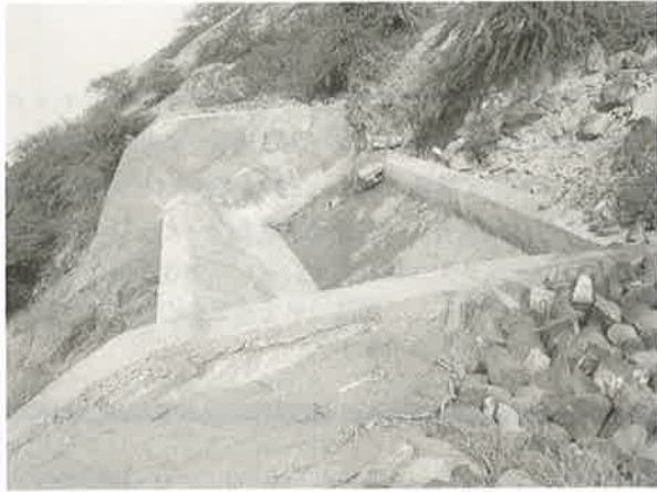
カブダ北方10kmに完成したチェックダム
