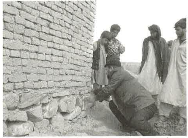
基礎部分の石組みが雑な構造を指摘するラーマン氏
