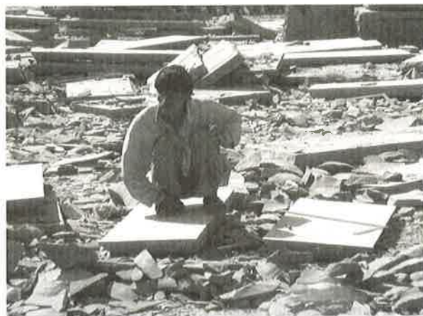
アグラ城の修理工(アグラ)
