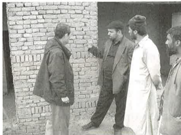
干しレンガシェルターの壁
