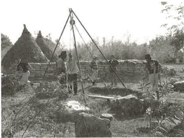
工事途中の様子
