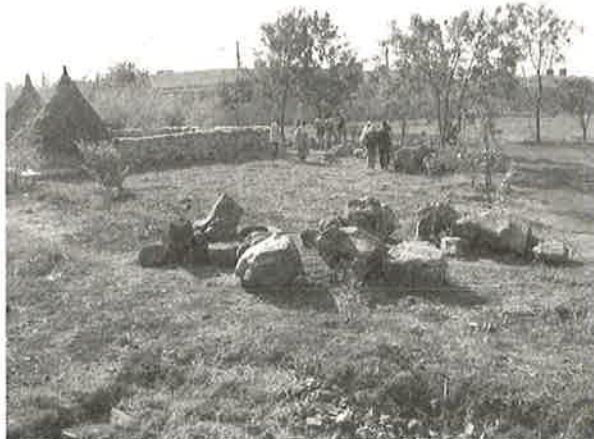
工事前の庭園(後には2001年建築のボンガがある)
