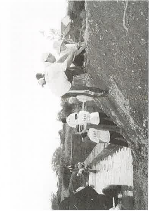
E4 建設後のバラチャリー・チェックダムの土手にも竹を移植
