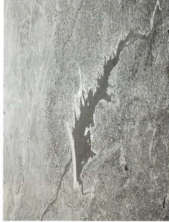
写真4 米国ネバダ州山岳地帯にあるチェックダム。ロサンゼルスよりシアトルへ向かう途中、上空より鳥瞰した。雪解け水を巧みに貯水している。米国はこのような自然環境利用技術がうまい。(筆者撮影 UA1822より 2001年8月7日)
