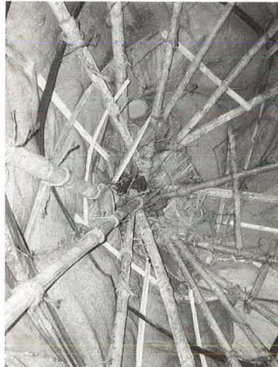
C3 C2の天井。竹を組み合わせて屋根枠としている。 本隊が作ったボンガの天井と内部は同じ構造。
